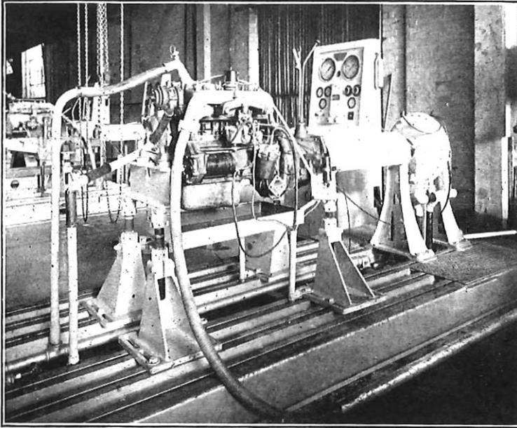
FIG. 6.—BENNETT FEREGAN DYNAMOMETER.
