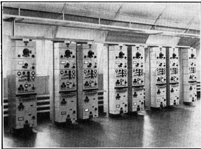
FIG. 11.—INDEPENDENT-SIDEBAND RECEIVERS AT BEARLEY RADIO STATION.
