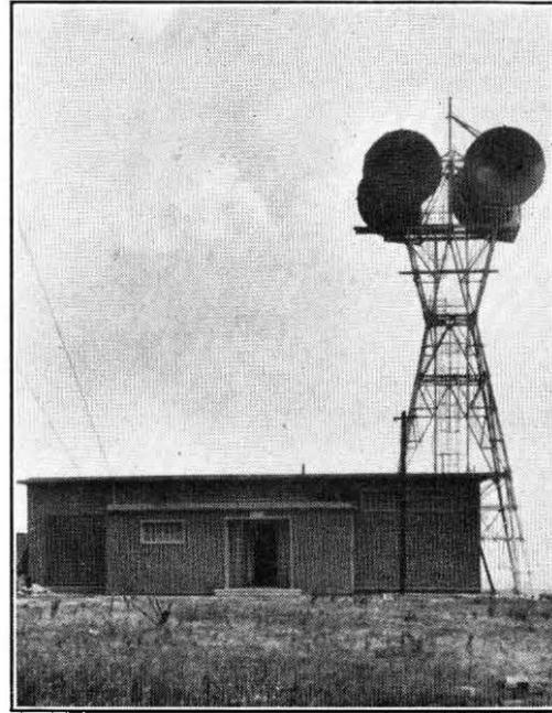
FIG. 10.—CORBY'S CRAG, INTERMEDIATE STATION ON MANCHESTER-KIRK O'SHOTT'S RADIO-RELAY LINK.
