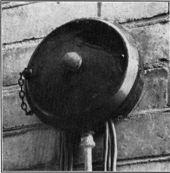
FIG. 9.—MODERN TERMINAL BLOCK.
